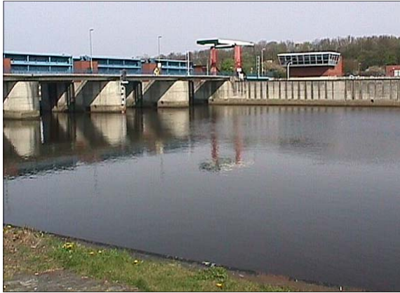
Slussar, dammanläggningar, vattenverk, hamnanläggningar etc.
